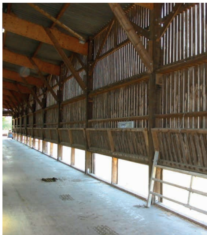
Photo 10 volets en partie basse (Crédit photo : Idele)
