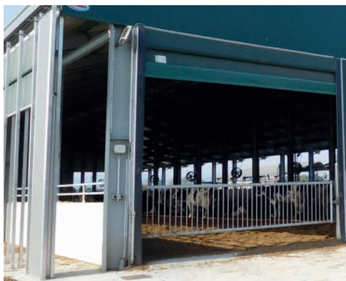
Photo 6. Brise-vent déporté (Crédit : photo BTPL)
