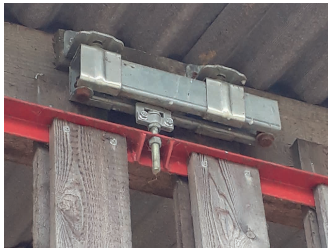
Photo 15 bardage bois modulable (Crédit photo : Idele)
