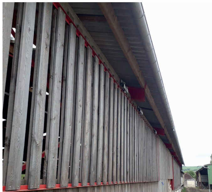
Photo 14 bardage bois modulable (Crédit photo : Idele)
