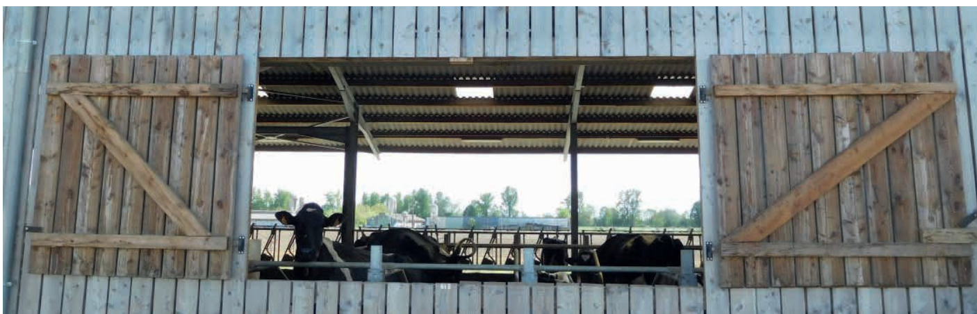
Photo 13 volets bois (Crédit photo : Btpl)
